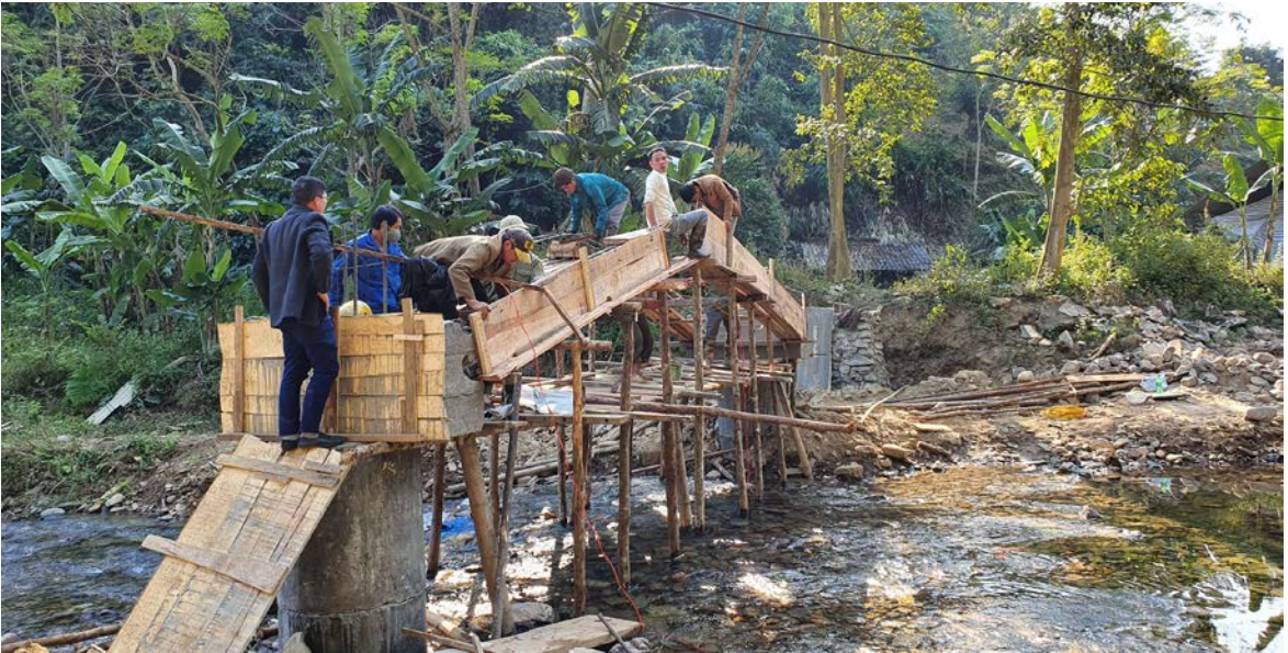
Việc giám sát, thi công công trình được đảm bảo một cách nghiêm túc
